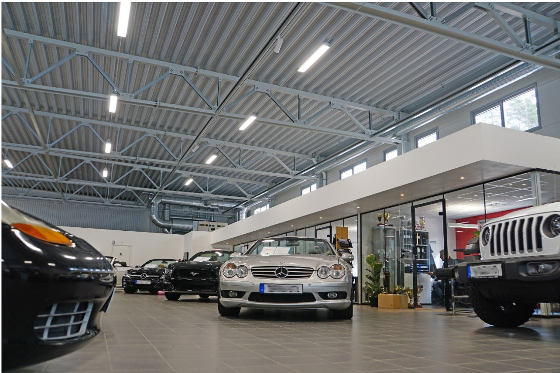
Bildetekst: Innertak med Borgas høyprofilplate
